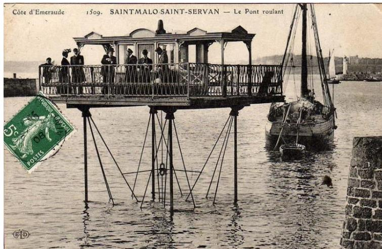
*Le pont roulant à marée haute. On voit distinctement la structure en fers entrecroisés et la cabine centrale avec sa partie fermée, ses parties couvertes et les bancs extérieurs. Source Internet.*
