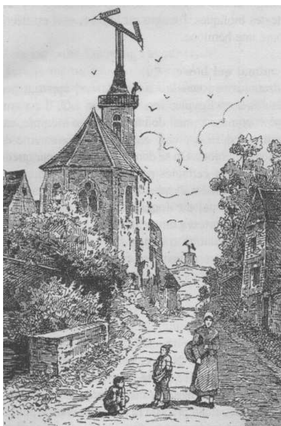
Système Chappe installé sur un clocher
